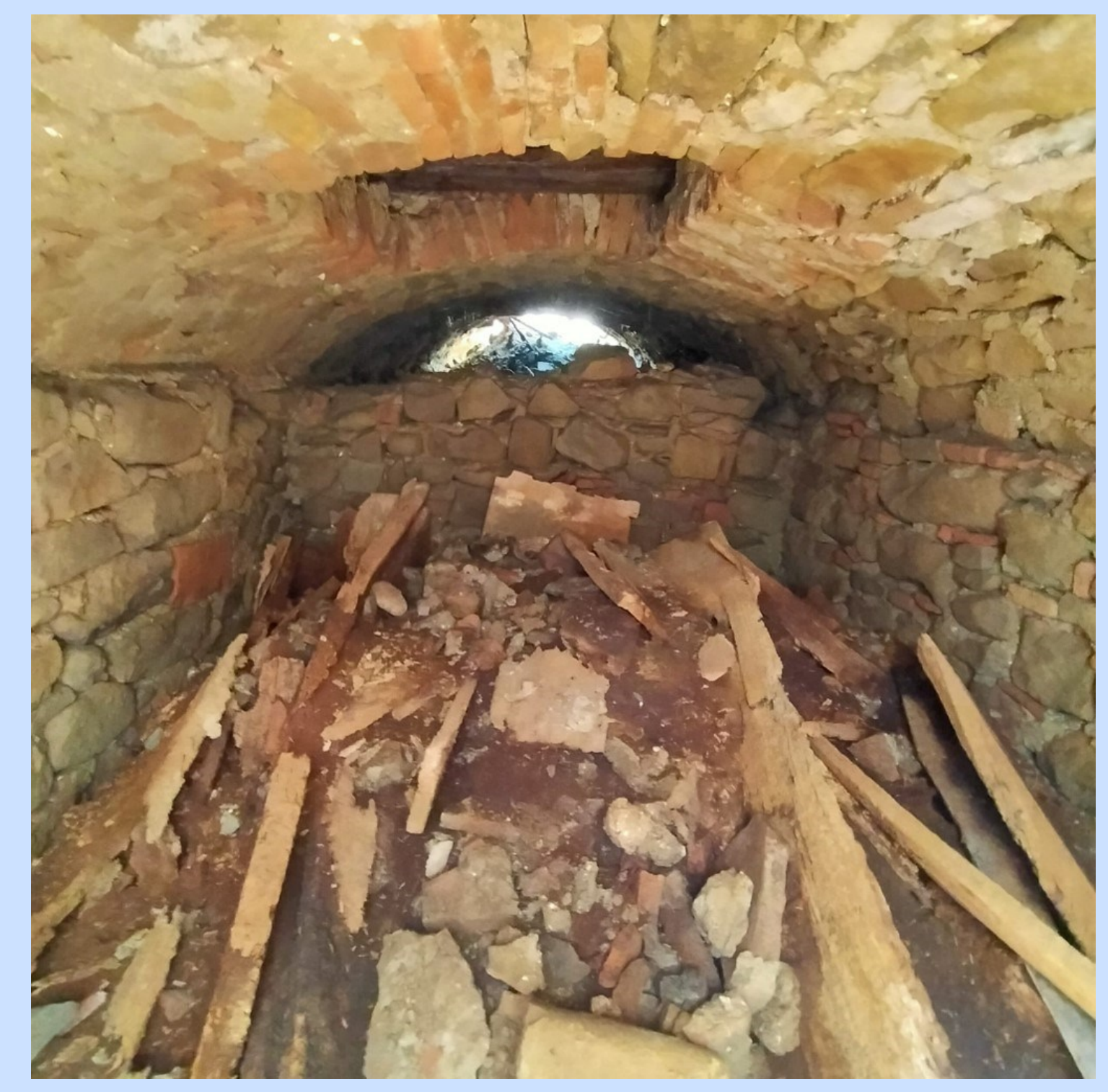
Camere ipogee poste al disotto della chiesa di S. Francesco ad Amatrice.
